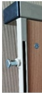
Sivulaidan yläosan lukituspainike/kiinnitystappi
